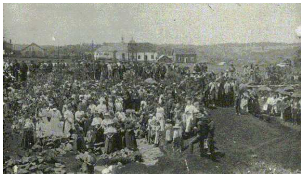
Foto 03 - Lançamento da pedra fundamental da Igreja
